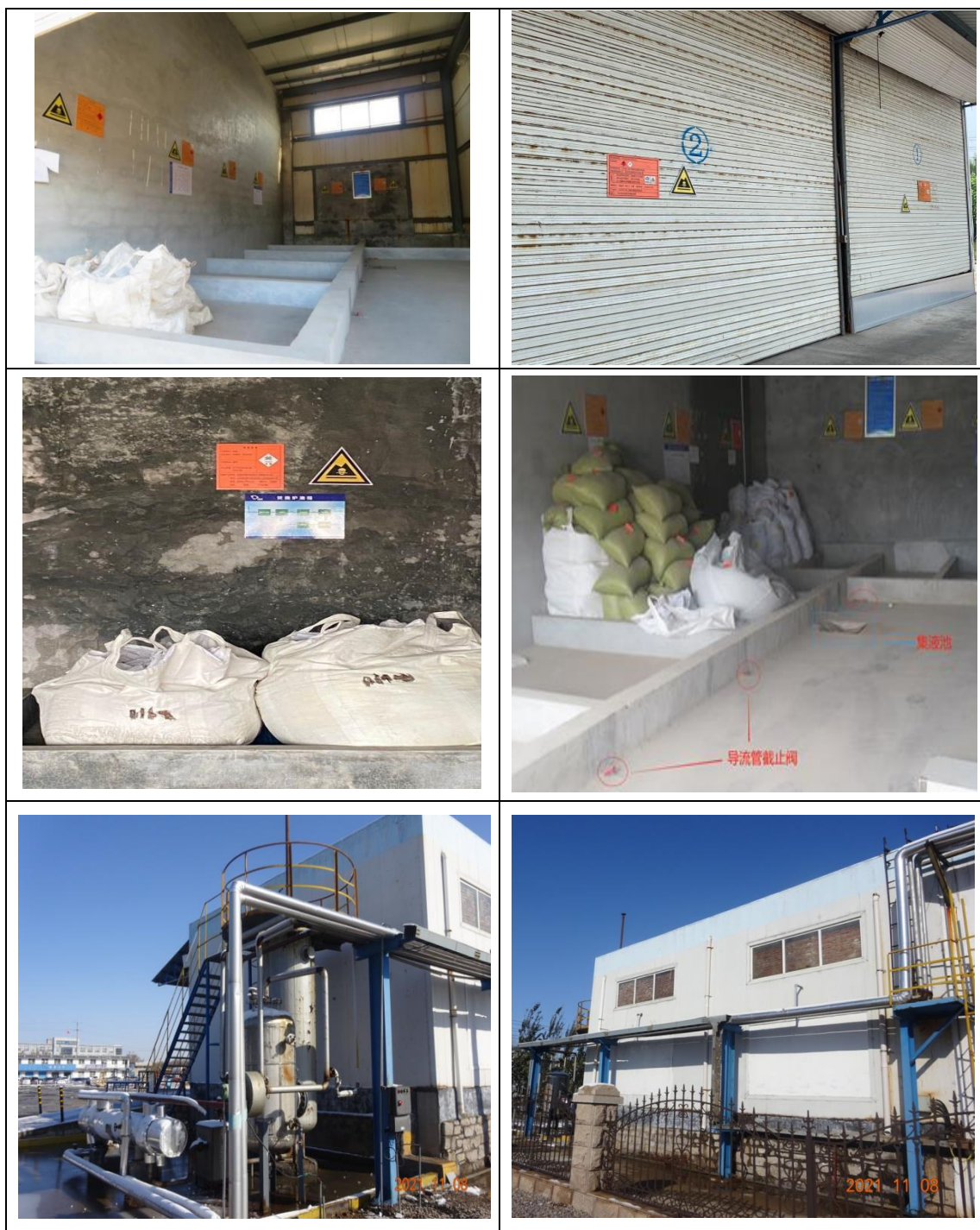
图 14.3-1 企业现有危废暂存间现场（内部、外部、废气收集）情况
